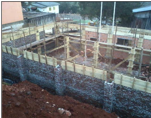
FOTO 01 – Estrutural da Obra
